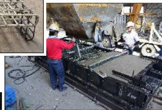
プレキャストコンクリートの打設
